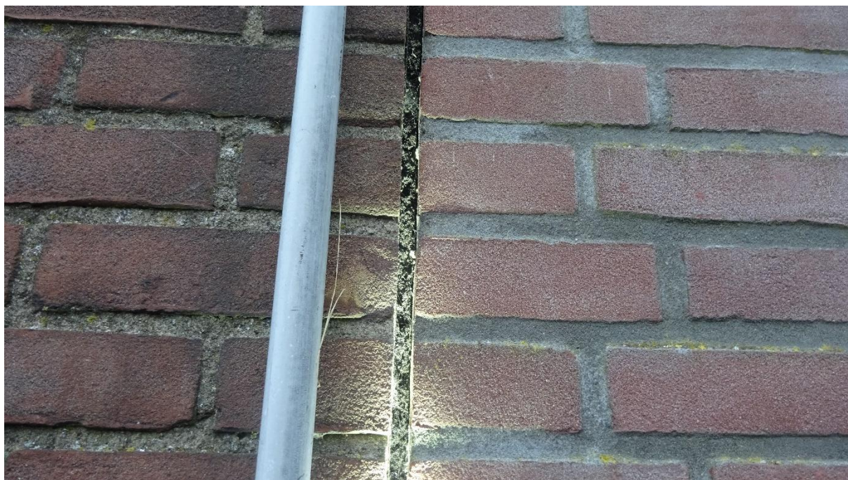
Foto 9: Met cellenband afgesloten dilatatievoeg.
