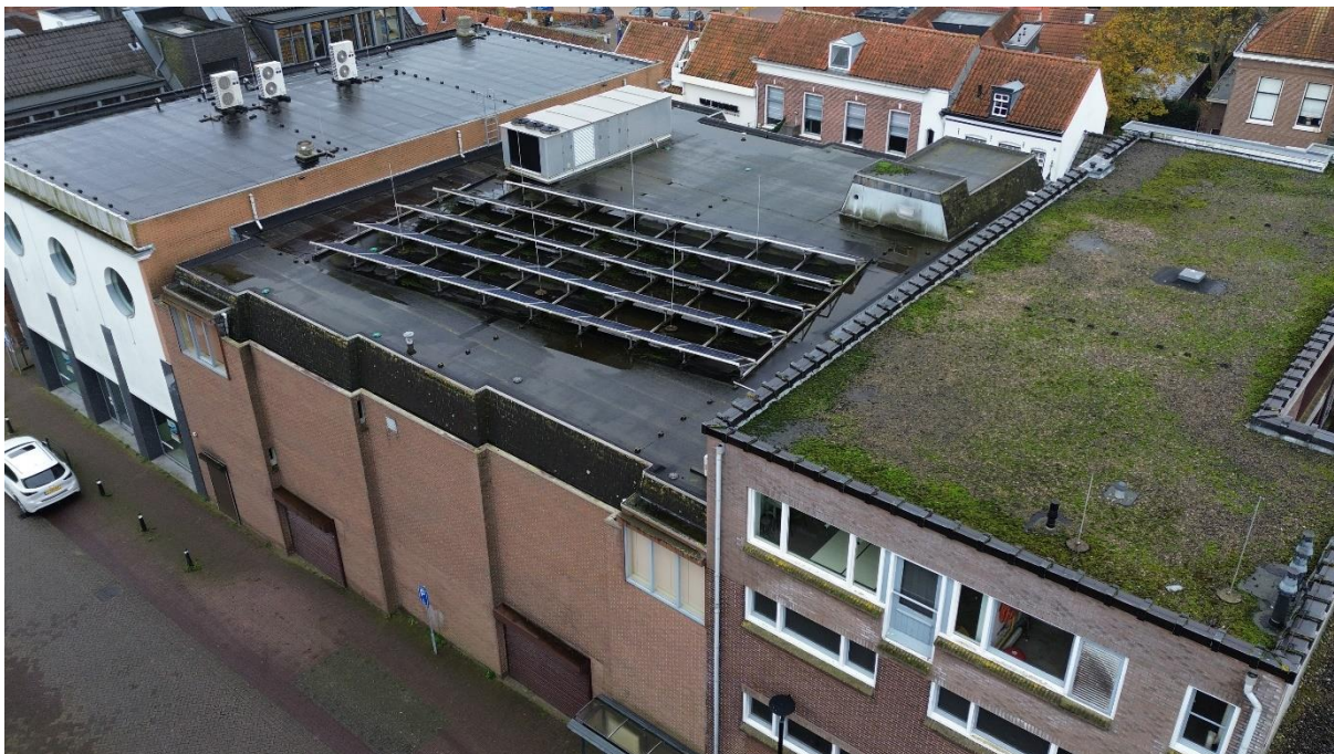
foto 4: Dakvlakken gezien vanuit noordoostelijke richting.
