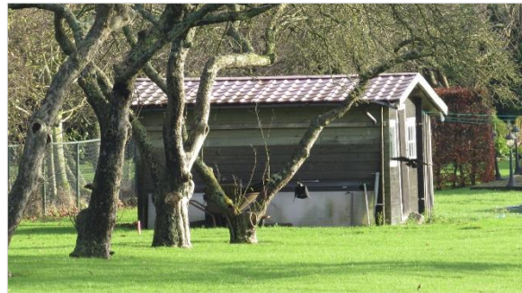
Figuur 4.2 Schuurtje gelegen in het oostelijke deel van de onderzoekslocatie.
