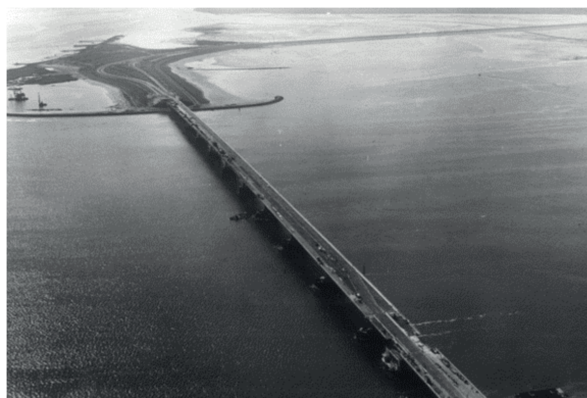
Afb 6.7 Voltooing van de Haringvlietbrug in 1964
