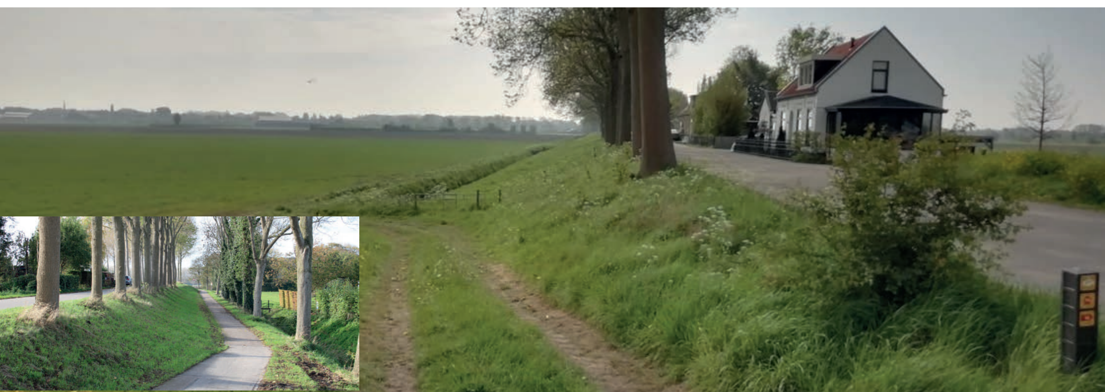
Afb 3.8 De Westdijk bij Mijnsheerenland vormt de westelijke begrenzing van de polder Mijnsheerenland van Moerkerken. Hier is tevens duidelijk te zien dat de dijk aan de buitenkant enigszins flauw afloopt, in tegenstelling tot de steile binnenzijde (inzet Schuringsdijk)
