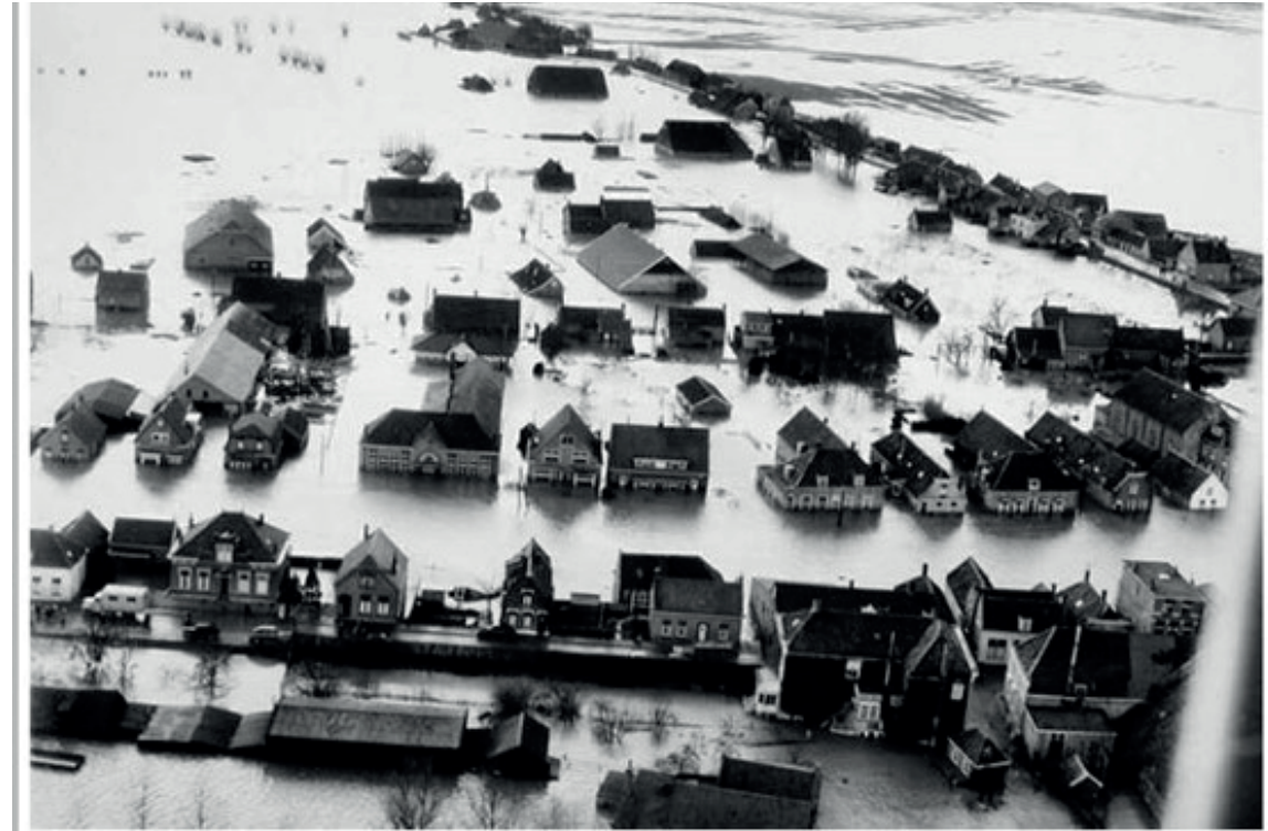
Afb 6.1 Foto van het Land van Essche, kort na de overstroming van 1953
