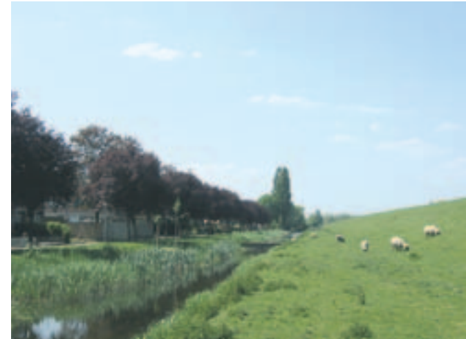
Primaire dijk zonder beplanting bij Heinenoord
