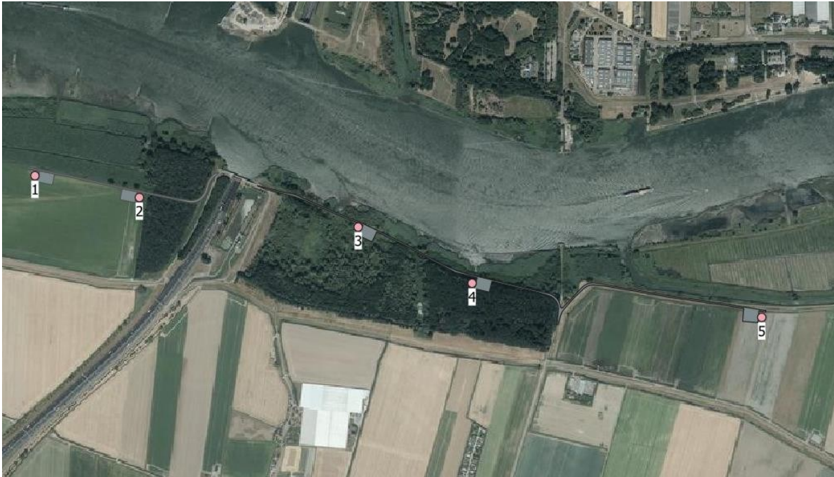
Figuur 1 Overzicht windpark Oude Maas
