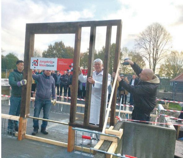
Wethouder Van Leenen assisteert de medewerkers van HW werkt! bij het plaatsen van een houten wand bij de stal.
